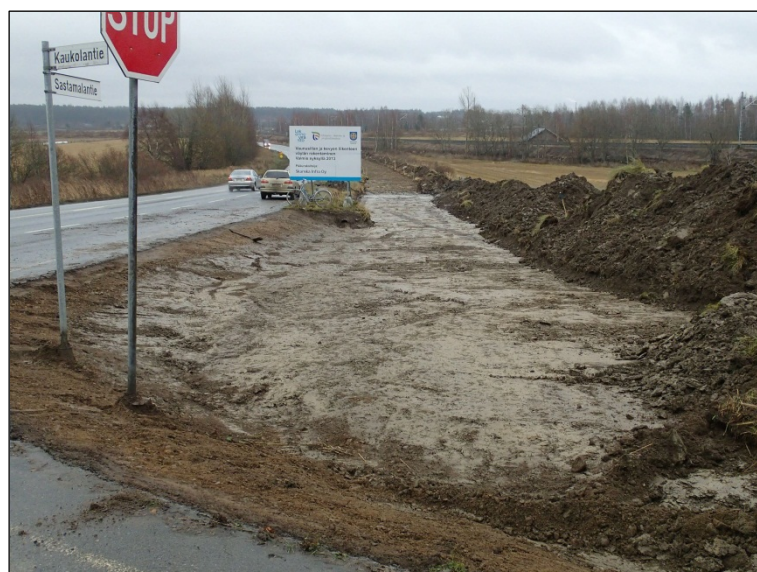
Valvottava osuus kaivettuna kyntökerroksen alle. Tämän syvemmälle ei kevyenliikenteen väylää perusteta eikä syvemmälle rakennustyössä kaiveta
